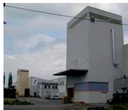
Granulatsilotürme mit Produktionshalle
